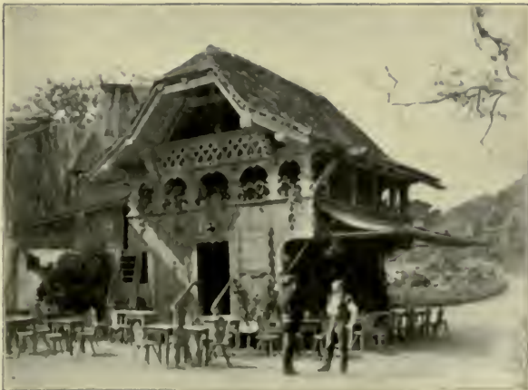
FIG. 7.—CHALET AT LANGNAU.
