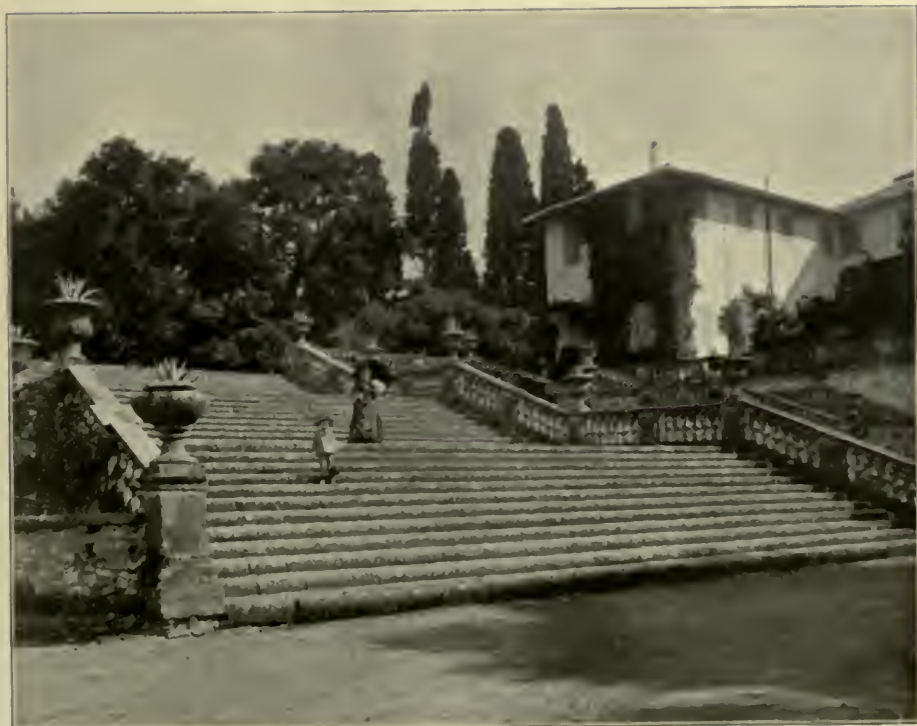
A PART OF THE GRAND STAIRCASE, VILLA CONTI, FRASCATI.
